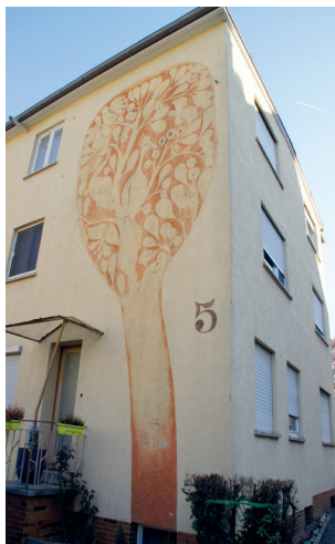
Wandbild Ebersbacher Straße 5
