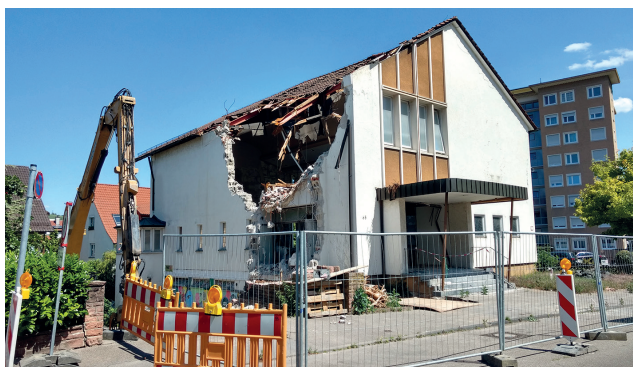
Der Abriss wurde wegen brütender Spatzen erst 2021 zu Ende gebracht
