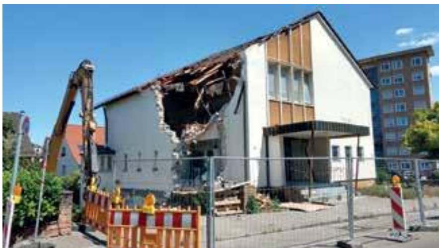
Neuapostolischen Kirche Abriss der Methodistischen Kirche (Juni 2020 – der Abriss wurde wegen brütender Spatzen gestoppt und erst 2021 zu Ende gebracht)
