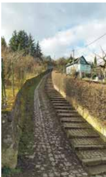
Die Faultannenfurche beginnt am oberen Ausgang des Friedhofs
